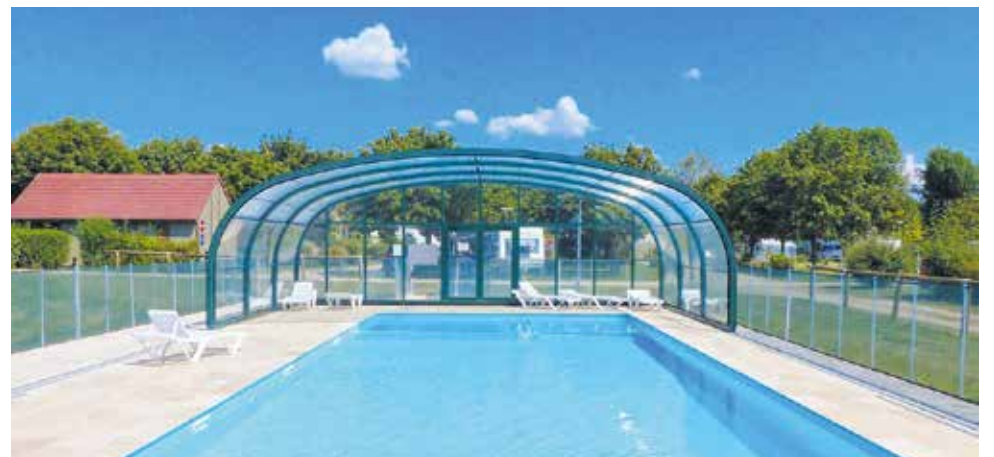
La piscine à toit escamotable du camping de Romorantin.
